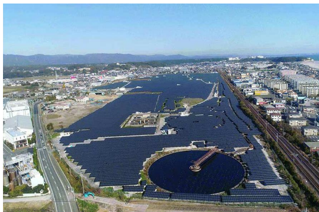
<高萩安良川太陽光発電所の外観>
