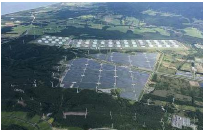
<上北六ヶ所太陽光発電所の外観>
