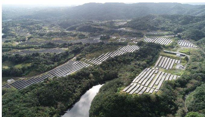
<鳥羽太陽光発電所の外観>
