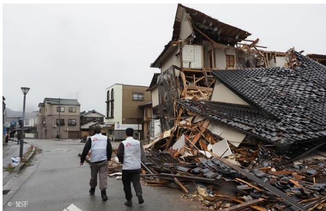
輪島市内の被災現場を歩く 国境なき医師団スタッフ
