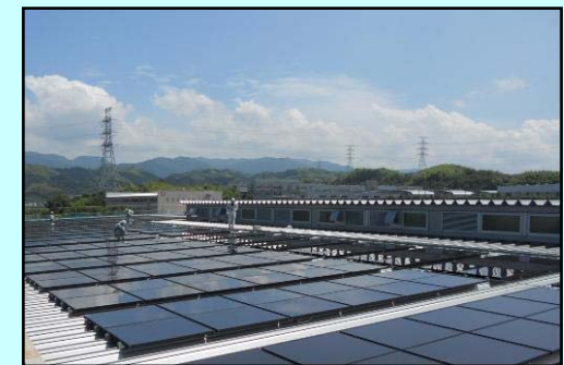
取引先の工場に導入した太陽光発電システム
