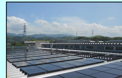
太陽光発電システム
