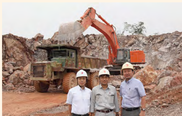
江南-小野田水泥有限公司さまが製造するセメントは、品質の高さから、強度を要する橋梁や地下鉄などに利用されています。
