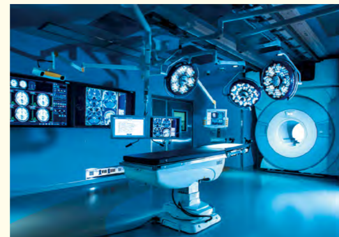
筑波大学附属病院さまでは、中規模・大規模手術室を新設し、また手術件数増加への対応のため、重症病床も増床されました。
